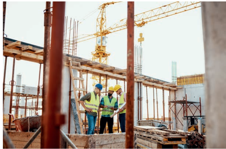
Nachhaltige Realisierung von Immobilien: Neubauten
